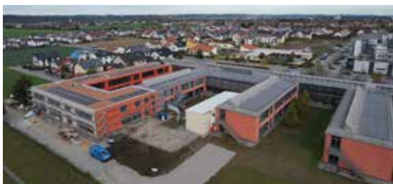
Luftaufnahme von der Baustelle an der Mittelschule
