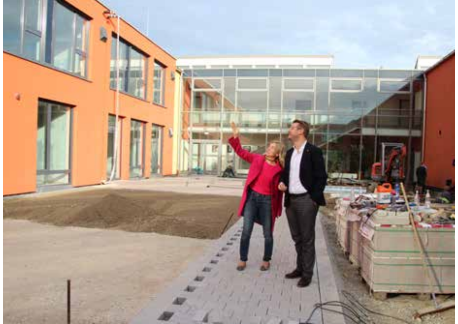
Stadtbaumeisterin Birgit Weichselgartner und 1. Bürgermeister Michael Hetzl besichtigen die Baustelle an der Mittelschule
